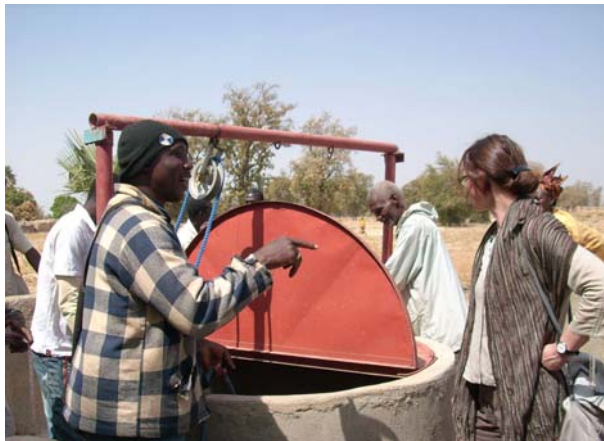
Neuer Trinkwasserbrunnen in Clanabougou
