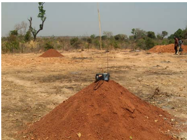
Aufgenommen bei Grabungsarbeiten für einen Brunnen
